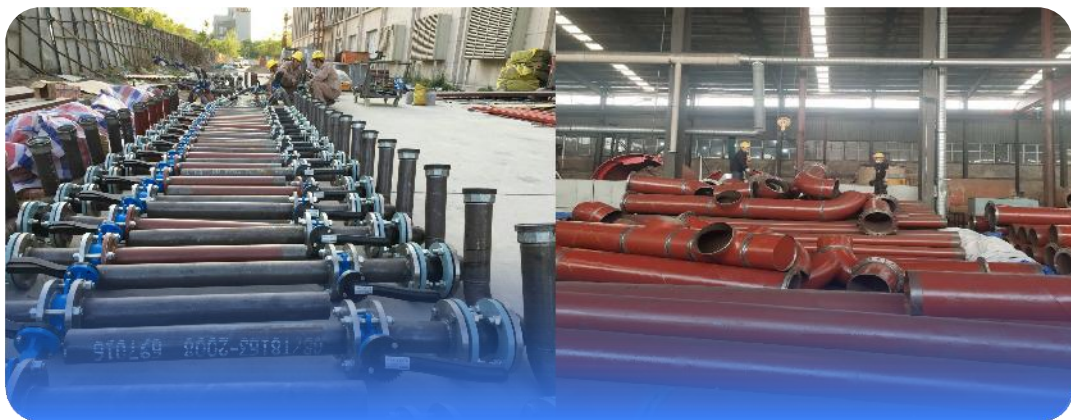
管道预制，现场安装
