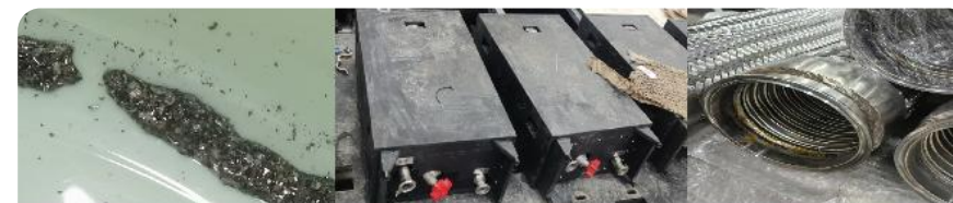
二次侧：部件级腐蚀、实施环境脏乱
